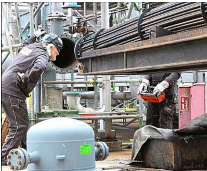
Millimetersache: Ein Wärmetauscher-Bündel (links) wird per Hand (im Hintergrund) gesteuert, aber maschinell eingeschoben. Kräne, Absperungen, Gerüste: Nicht überall ist zurzeit ein Durchkommen auf dem Betriebsgelände in Vohburg möglich. Fotos: Stefan Eberl
