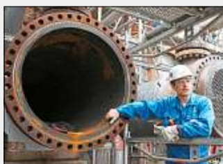
Tiefe Einblicke: Tobias Bauer an einem Wärmetauscher-Rohr. Bolzen werden gereinigt und geschmiert. Fotos: Stefan Eberl
