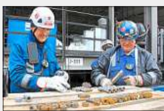
Tiefe Einblicke: Tobias Bauer an einem Wärmetauscher-Rohr. Bolzen werden gereinigt und geschmiert. Fotos: Stefan Eberl
