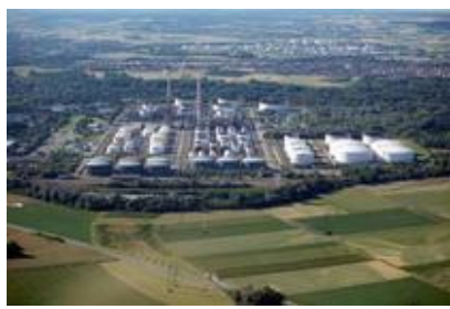
Eine Aufnahme des Bayernoil-Geländes, als die Raffinerie noch in Betrieb war. Jetzt wird für das Areal eine neue Nutzung gesucht.
