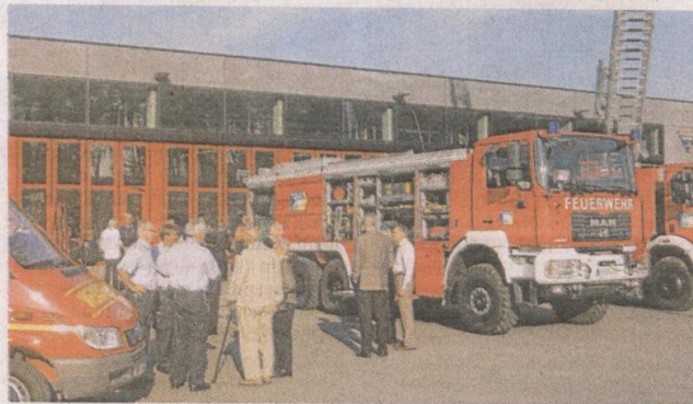
Nach nur einem Jahr Bauzeit wurde die neue Feuerwache bezogen. Fotos: zar
