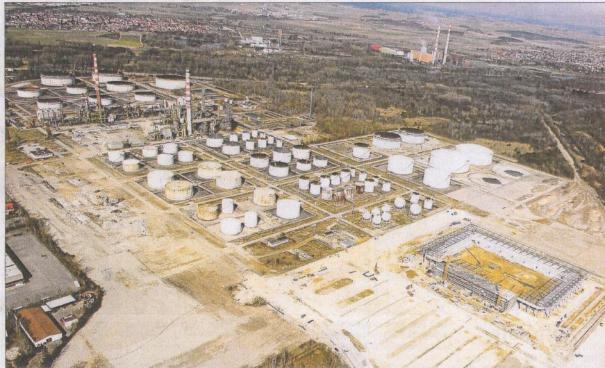
Die Demontage der Bayernoil-Anlagen schreitet voran. Inzwischen ist Platz geschaffen (im Bild links Mitte und unten) für die Verbindungsstraße von der Bruhnstraße zum Audi-Sportpark (rechts unten). Foto: Schalles
